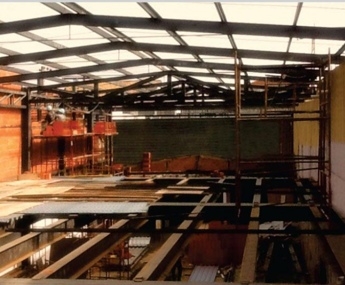
Confecções Caedu - Itu/SP- Fornecimento e execução de 4000m 2 de estrutura metálica
